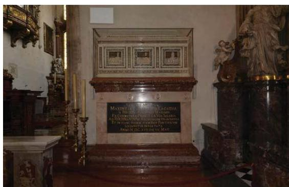
Beide Postamente der Braumtuhen bestehen aus einem dreifarbigen Steinaufbau. Das untere und obere profilierte Gesims besteht aus verschiedenen Adneter Varietäten (Lienbacher und Scheck), die Inschrifttafel aus einem schwarzen Kalkstein mit vergoldeter Inschrift, dessen Rahmung in weißem Marmor ausgeführt ist.
