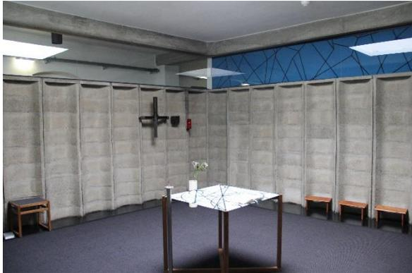
verwurzeln (Abb. 1). Die Kapelle ist als geometrischer Mittelpunkt im 2. Stockwerk des Studentenheims in der Leechgasse über dem Foyer angelegt. Der quadratische Raum mit den Grundrissmaßen von 6 x 6 Metern bildet sich aus gewölbten Betontrogsteinen bis in eine Höhe von etwa zwei Metern. Die geschwungene Form dieser Steine umgibt
